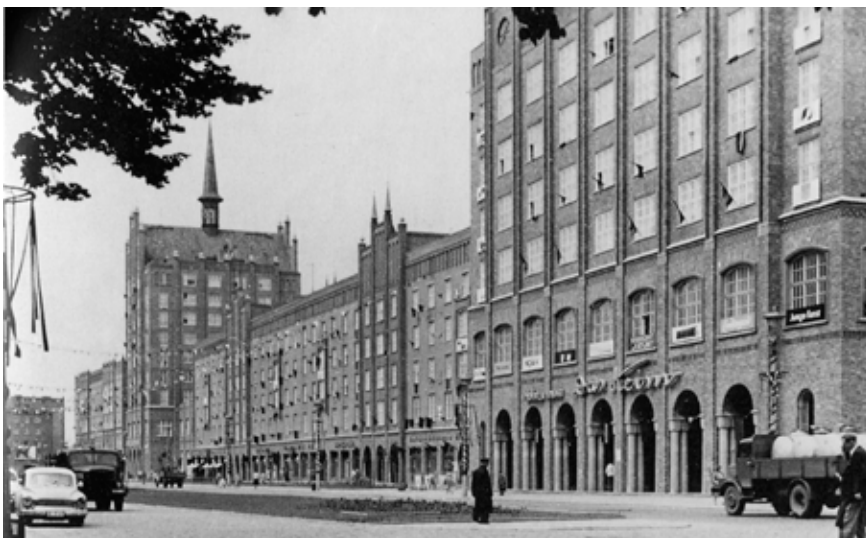
Abb. 35 Rostock, Lange Straße, Blick nach Nordwest, im Vordergrund Block D Nord, Straßenzug err. 1953-1958, Chef- architekt Joachim Näther, Aufnahme zwischen 1958 (Richt- fest des Hochhauses im Hintergrund) und 1961 (Inbetriebnahme der Straßenbahn in der Straßenmitte).
