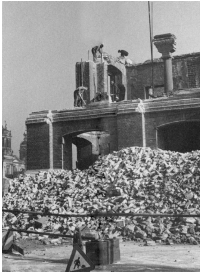
Abb. 58 Berlin, Bauakademie, nach Entwurf von Karl Friedrich Schinkel er- richtet 1832-1836, Ab- brucharbeiten und Ber- gung der plastischen Terrakotta-Teile, Aufnahme 1961.
