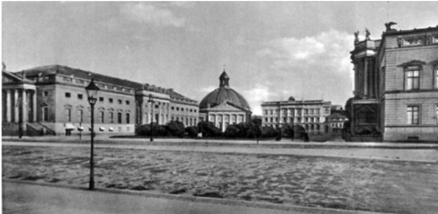
Abb. 20 Berlin, Bebelplatz, Ensemble aus Opern- haus, Hedwigskirche und weiteren Bauten, gesehen von Nord- west, Aufnahme wohl 1890er Jahre.
