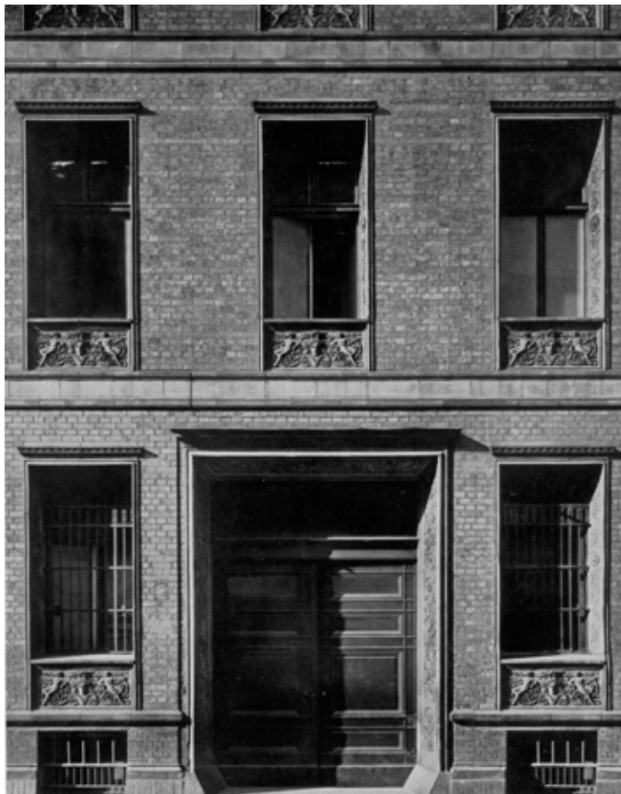
Abb. 12 Berlin, Feilnerhaus, Tor- und Fenstergliederung der Fassade, Entwurf Karl Friedrich Schinkel, Aufnahme um 1930.
