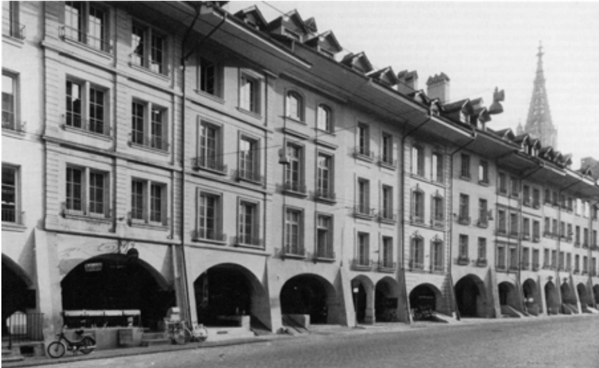
Abb. 31 Bern, Lauben der Unteren Altstadt, Auf- nahme 1987.
