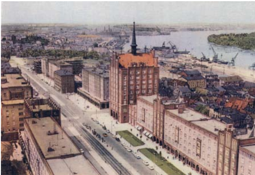
Abb. 34 Rostock, Lange Straße, Blick nach Nordwest, errichtet 1953-1958, Chefarchitekt Joachim Näther, Aufnahme um 1961.
