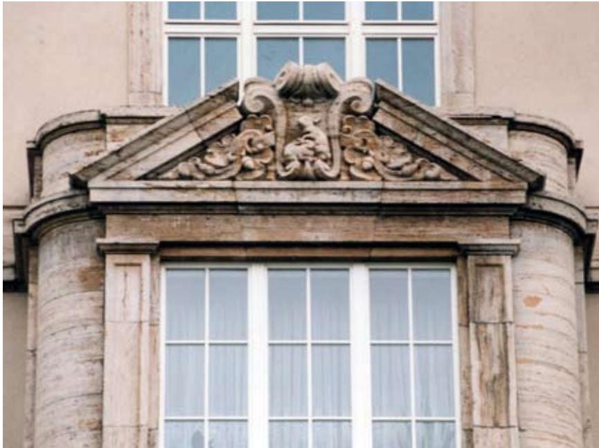
Abb. 53 Leipzig, Rossplatz 1-13, Detail der Be- bauung des südöst- lichen Ringabschnittes um die Altstadt, er- richtet 1953-1955, Chefarchitekt Rudolf Rohrer, Aufnahme 1999.
