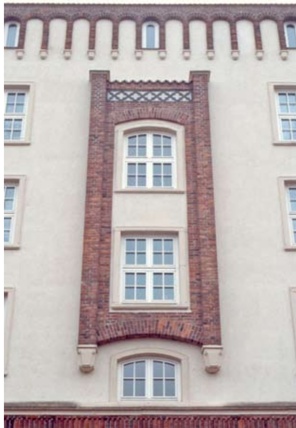
Abb. 38 Rostock, Lange Straße, Block D Nord, Erker, Straßenzug errichtet 1953-1958, Chefarchi- tekt Joachim Näther, verantwortliche Archi- tekten Block D Nord: Näther und Ernst Eick, Aufnahme 2001.
